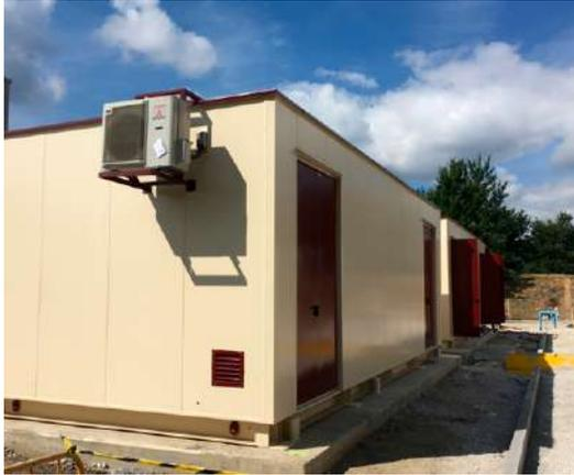
Módulo tipo CIAT de estructura metálica
