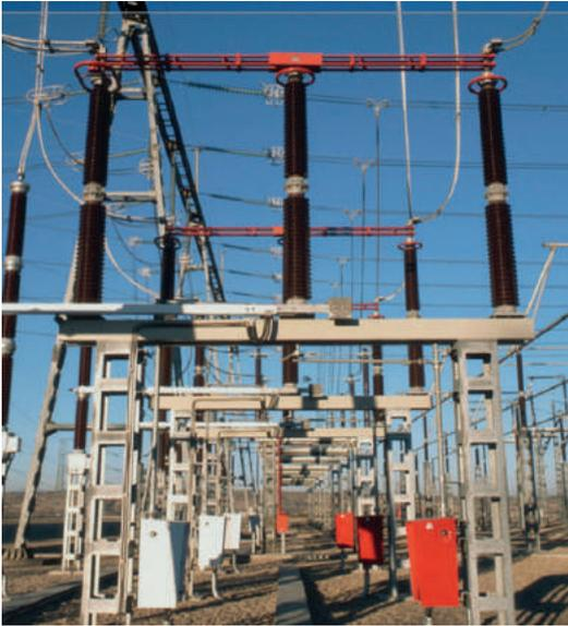
Se ha desarrollado un sistema de monitorización del estado de los seccionadores para mejorar su fiabilidad, reducir la frecuencia de periodos de mantenimiento y aumentar la seguridad reduciendo la presencia humana en terreno.
